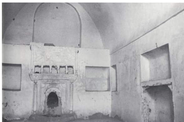
شکل ۱۳: داخل قلعه باغستان، این اتاق نشیمن متروکه، دیوار شومینه‌ای کنده‌کاری شده و رنگ‌آمیزی شده دارد. گچ قسمت پایین دیوار با سنگ صیقل داده شده بود تا مانند مرمر بدرخشد.
